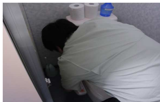
漏水チェック
