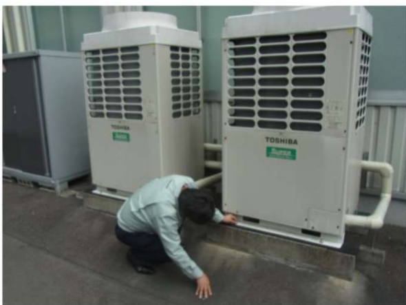
■ エアコン室外機の簡易点検の実施 2016年8月
